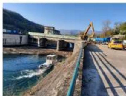
Récupération des bois au pied du barrage de Génissiat.
